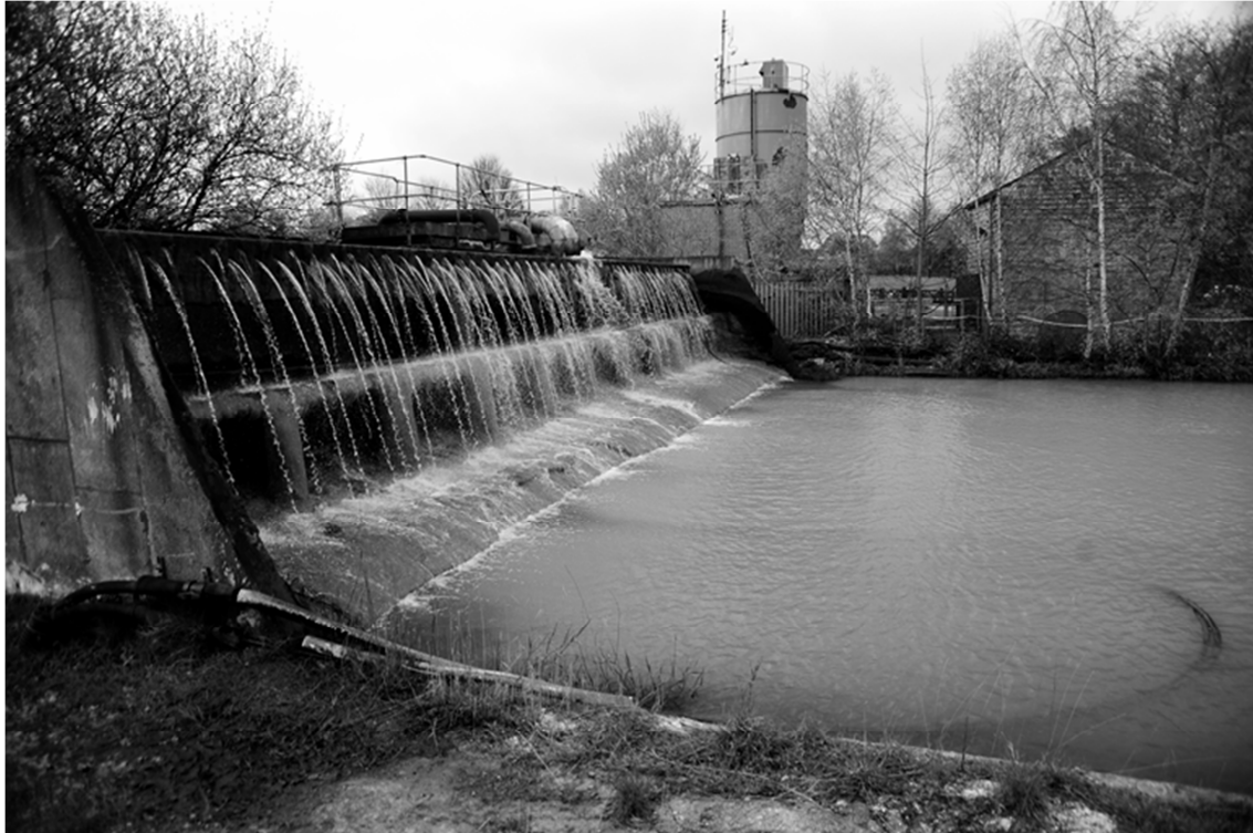
Bild 8: Enteisung auf dem Bergwerk Hope Pit / Overton, Wakefield
