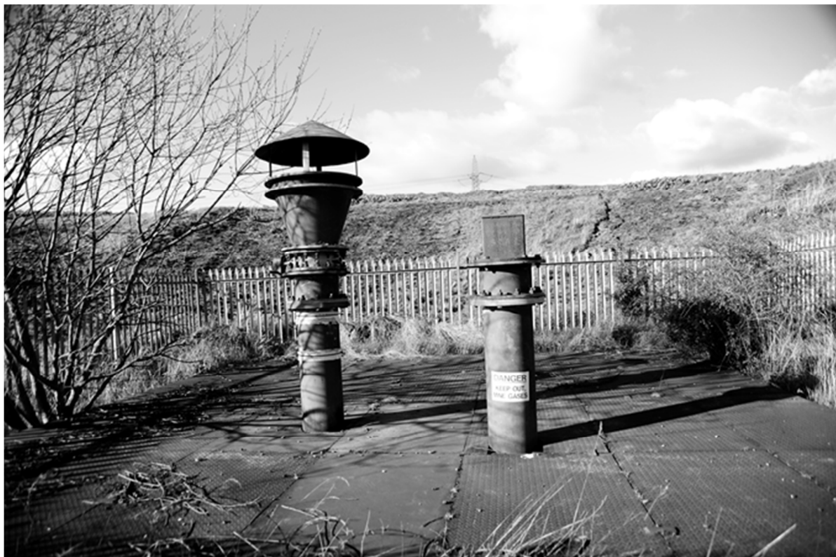
Bild 7 Verwahrter Schacht des Bergwerkes Thurcroft
